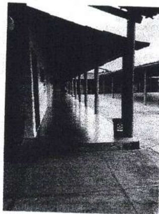
FOTO 8 - CIRCULAÇÃO DAS SALAS
