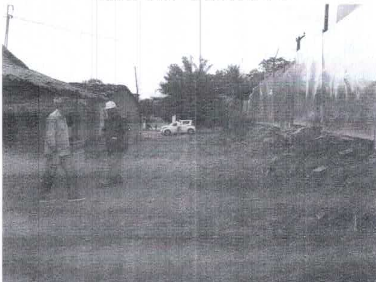
FIGURAS 01: Local do Muro de Contenção/Arrimo:
