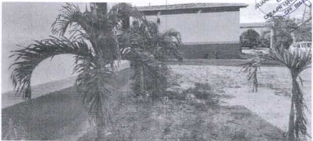
FIGURAS 04: Edificação onde será instalado o SAMU.
