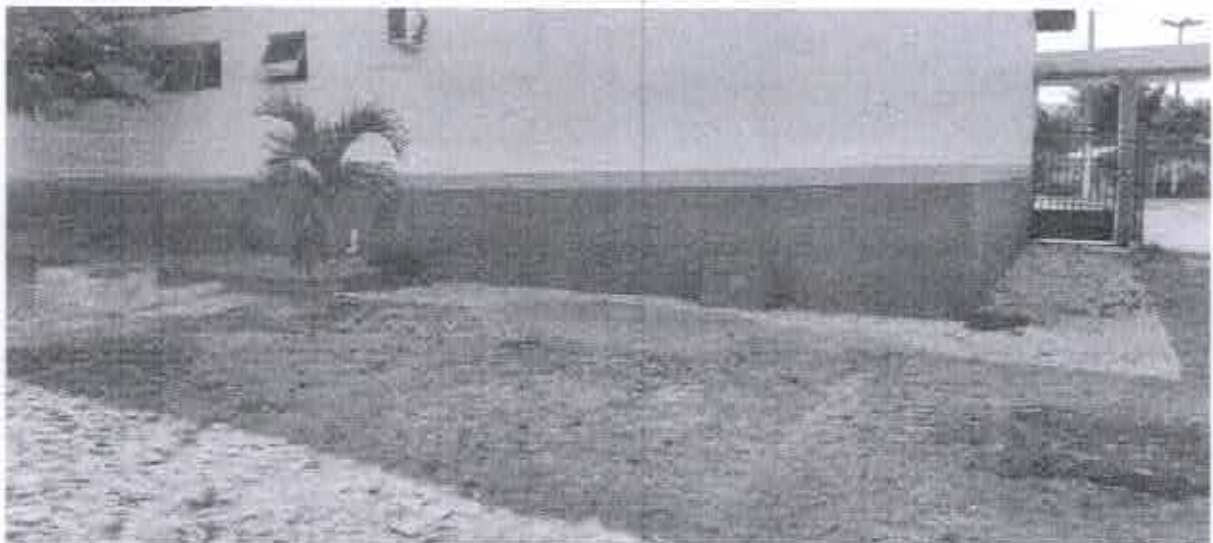
FIGURAS 03: Edificação onde será instalado o SAMU.
