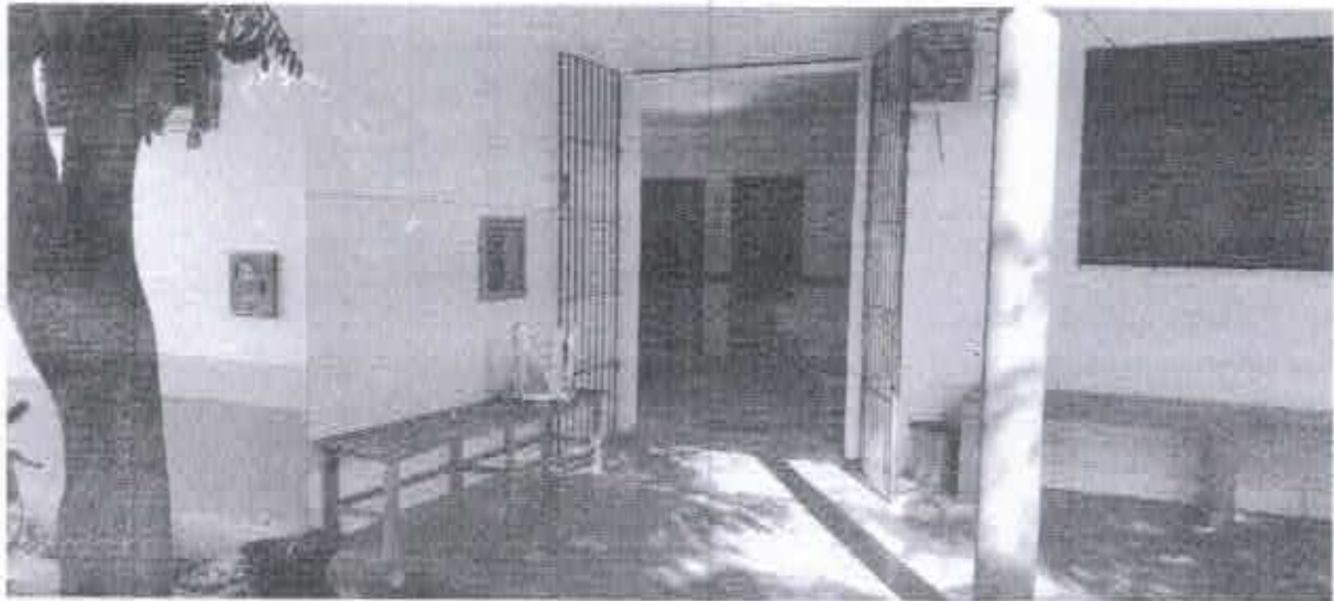
FIGURAS 05: Edificação onde será instalado o SAMU.
