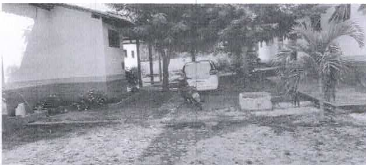
FIGURAS 01: Edificação onde será instalado o SAMU.
