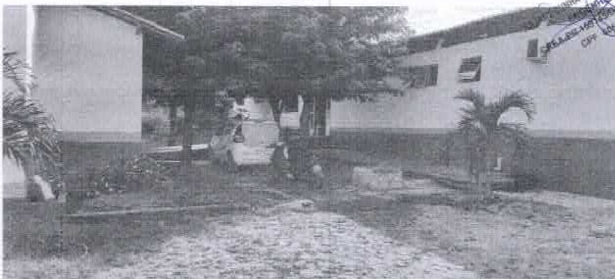
FIGURAS 02: Edificação onde será instalado o SAMU.
