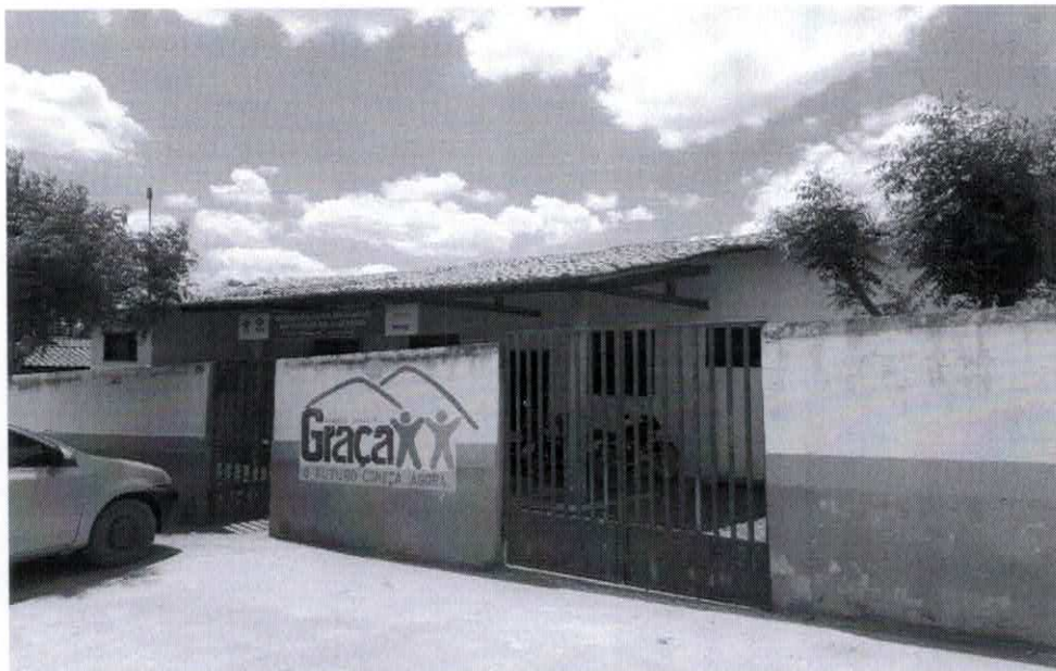
FIGURAS 08: Fachada do Posto de Saúde localizado na localidade de Caetano, município de Graça
