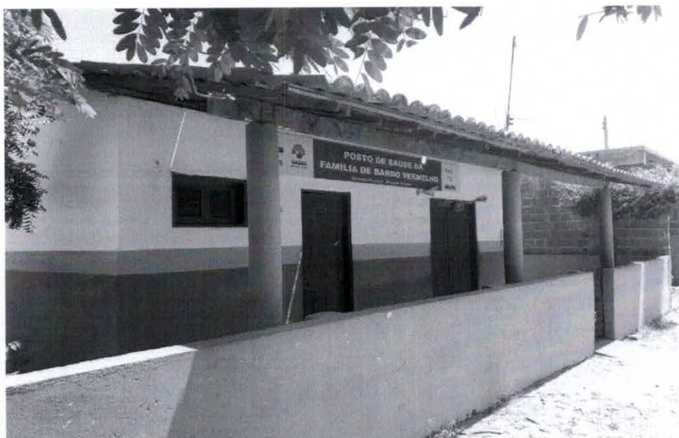
FIGURAS 06: Fachada do Posto de Saúde localizado na localidade de Barro Vermelho, município de Graça
