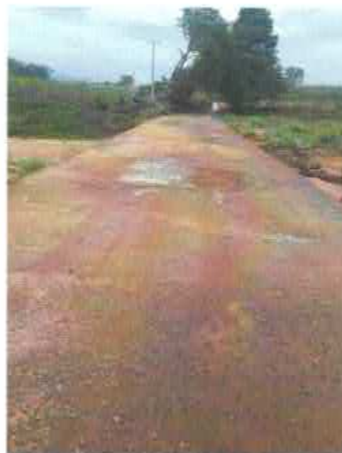
FIGURAS 03: Passagem Molhada - Rio Grande – Extremas dos Furtados
